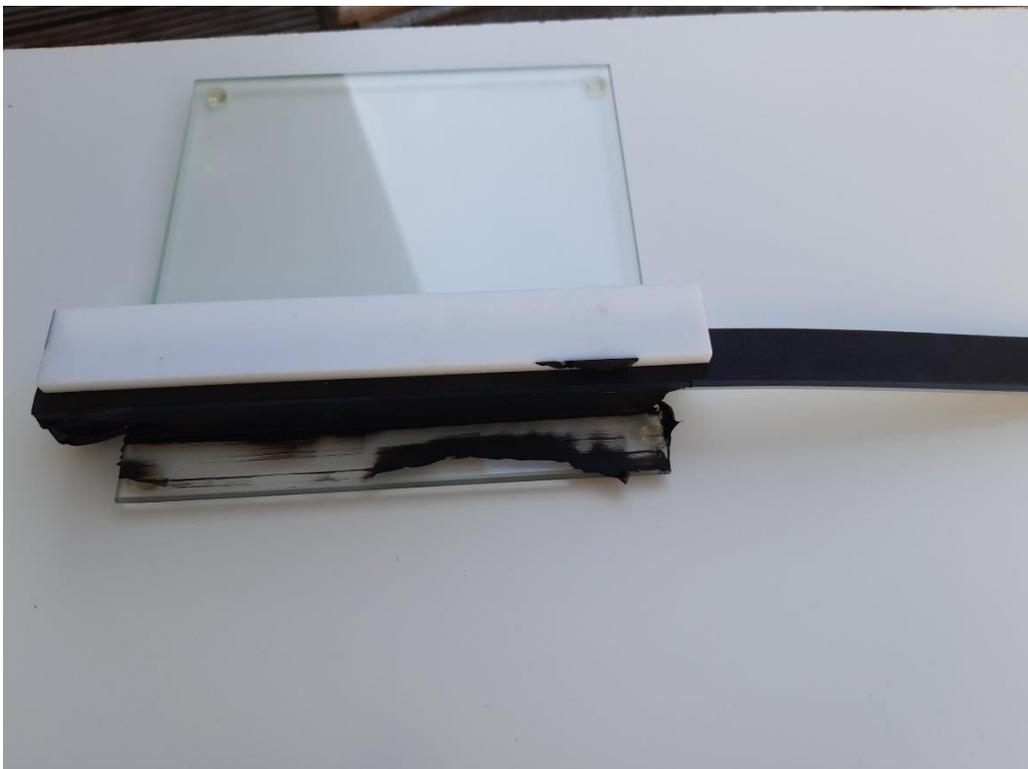
Nach 24 Std. des Aushärtens des Dichtstoffes entfernen Sie das Teflonprofil vom Abstandhalter.
